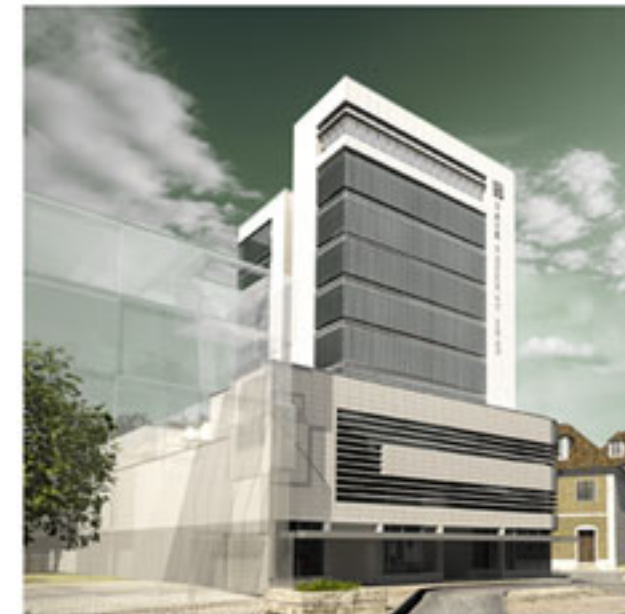
دید جبهه جنوب شرقی
