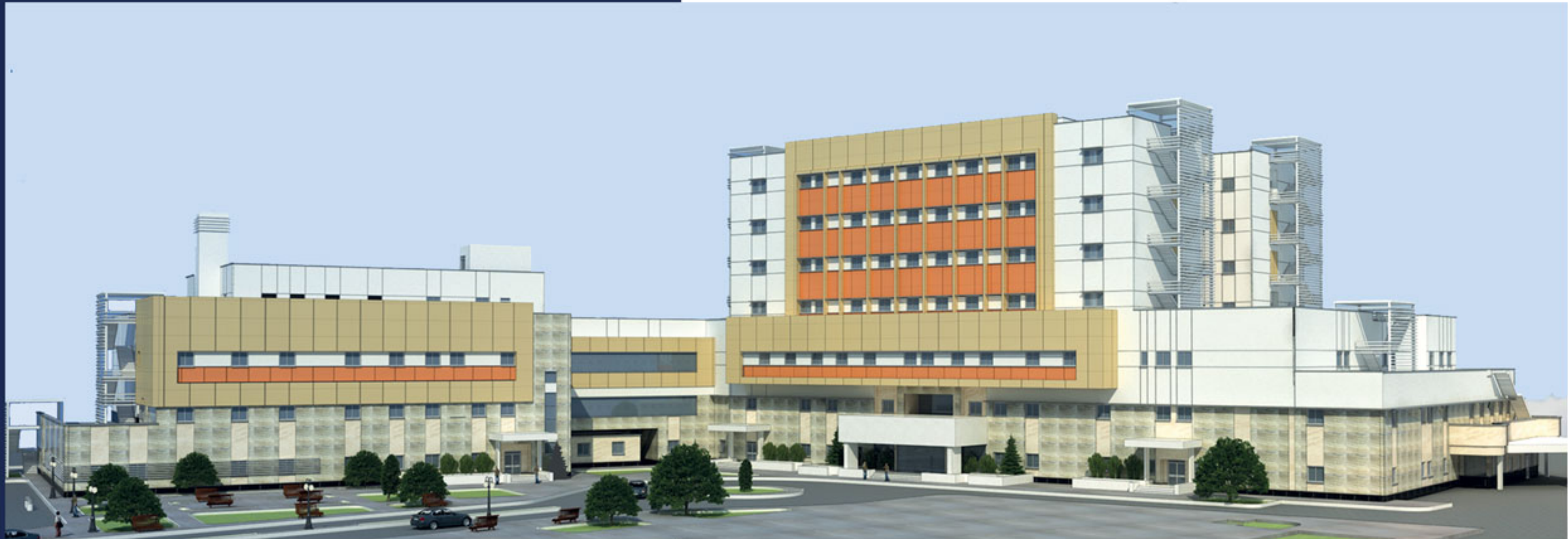
دید کلی مجموعه شروع عملیات اجرایی از سال ۱۳۸۸
