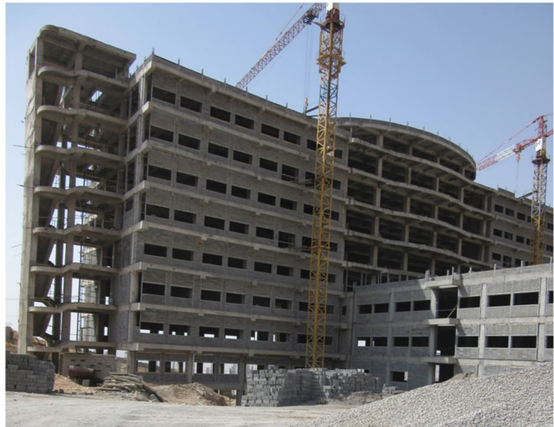
سازه اجرایی پروژه (دید از جبهه جنوبی)
