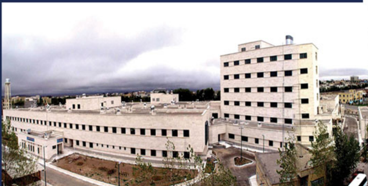
دید جنوبی مجموعه
